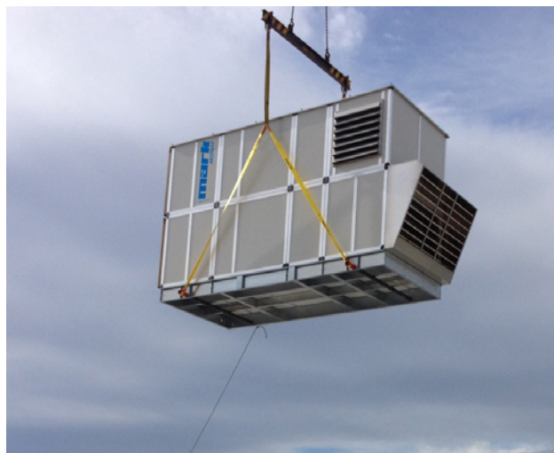
Unit die op het dak gehesen wordt.
