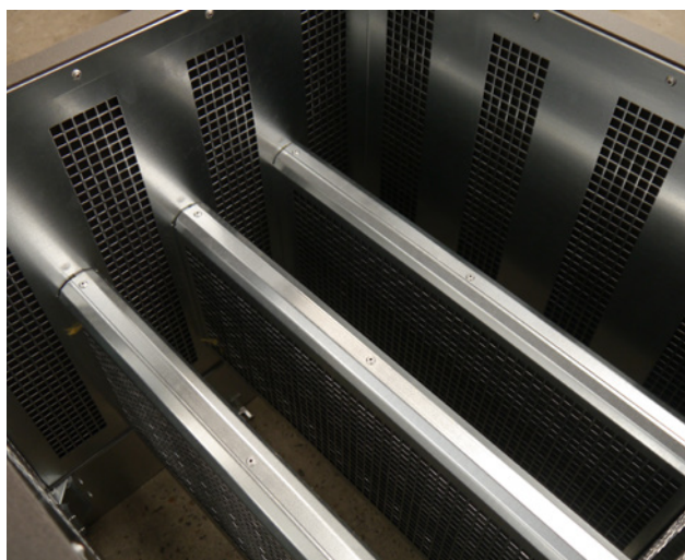
Dakopstand met demper
